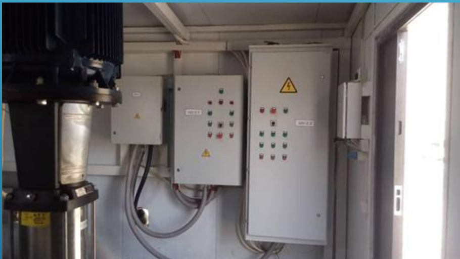
автоматизированные повысительные насосные станции для технического и питьевого водоснабжения
