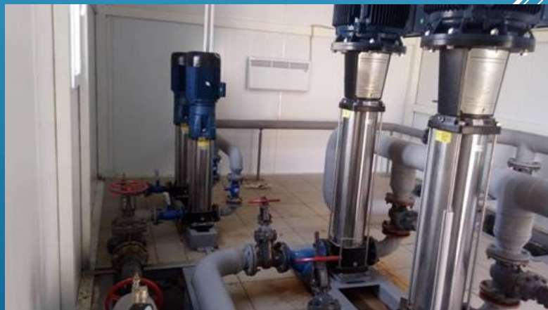
автоматизированные повысительные насосные станции для технического и питьевого водоснабжения
